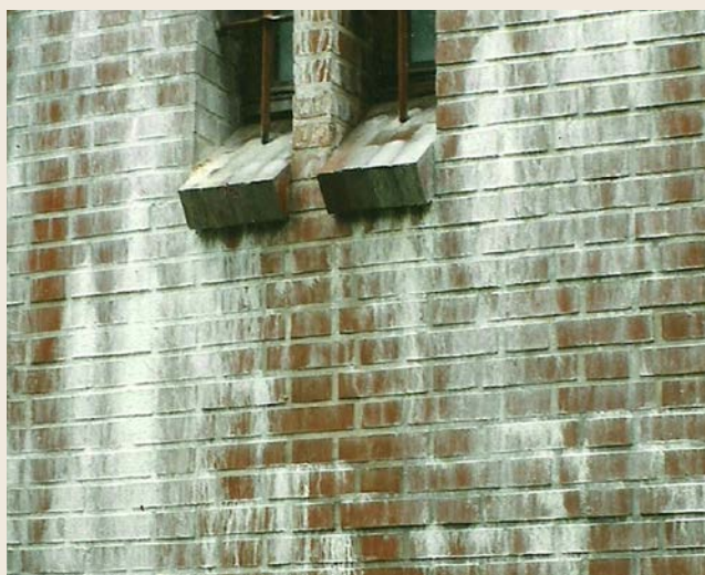
Zniszczenia lica cegieł w zabytkowym murze przez zbyt szczelną i zawierającą sole budowlane zaprawę z cementu portlandzkiego.
