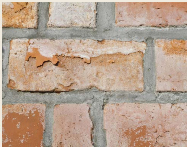
Zniszczenia lica cegieł w zabytkowym murze przez zbyt szczelną i zawierającą sole budowlane zaprawę z cementu portlandzkiego.
